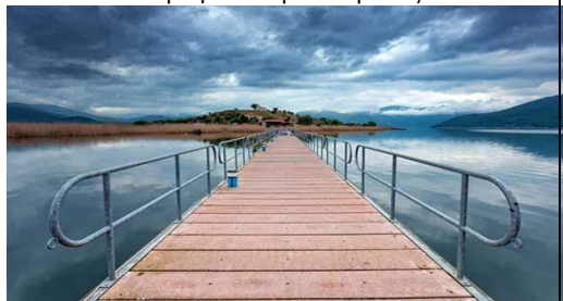
Η Γέφυρα του Αγίου Αχιλλείου.
