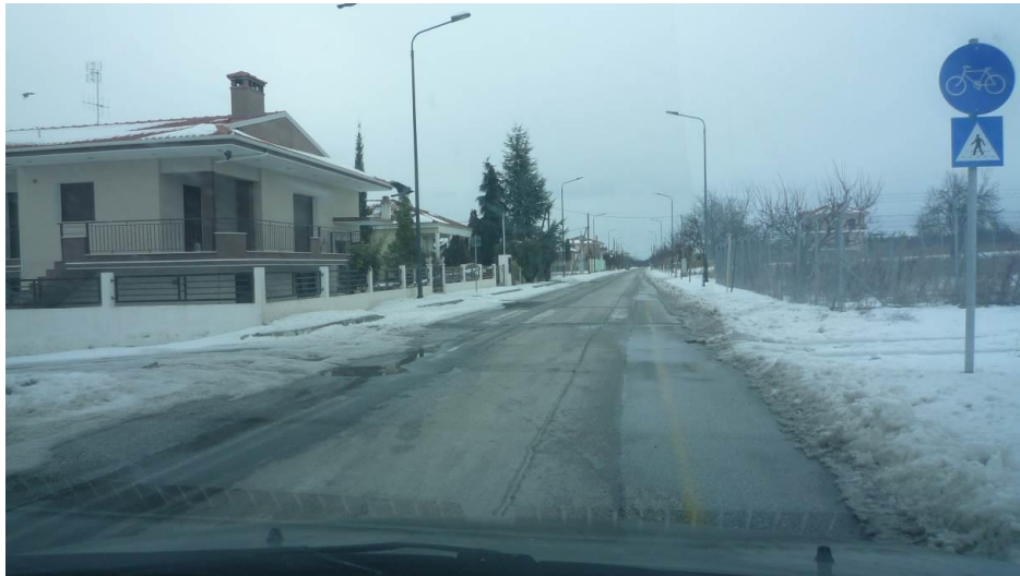
Φωτ. 3.3: ΝΑ περιφερειακής οδός – διέλευση νέου δικτύου ομβρίων.
