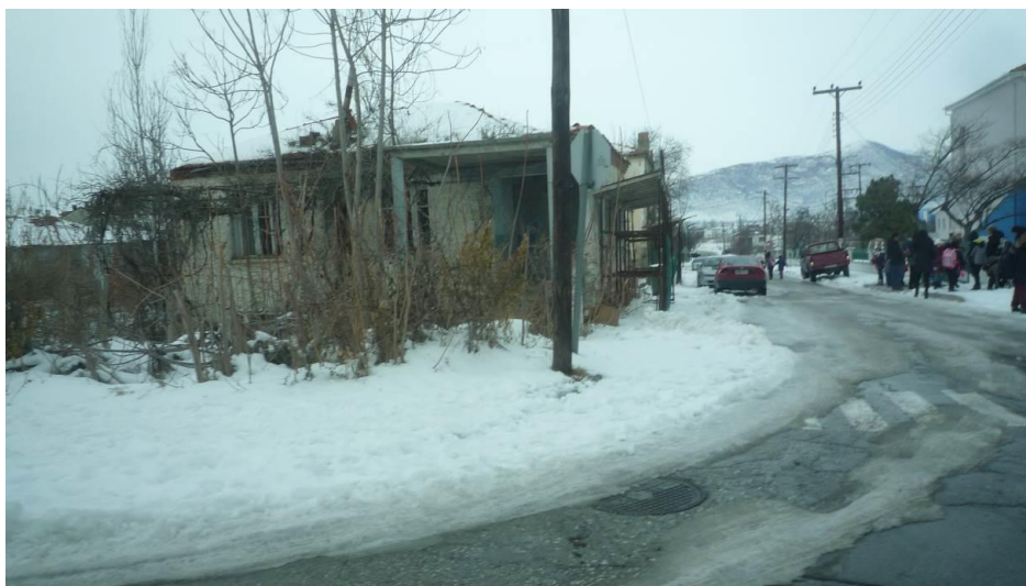
Φωτ. 3.4: Υφιστάμενο φρεάτιο με λήψη προς την οδό Αναλήψεως – νέο δίκτυο ομβρίων.
