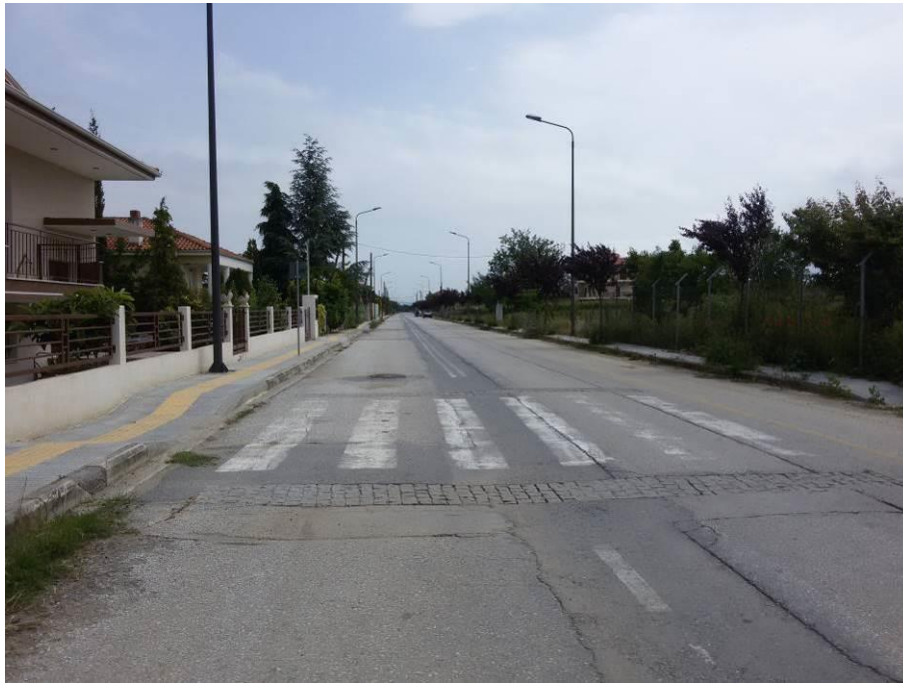
Φωτ. 4.14: Οδός Θανάση Χατζή, ΝΑ περιμετρικό δίκτυο κατασκευής του νέου δικτύου, πλησίον Ο.Τ. 149.
