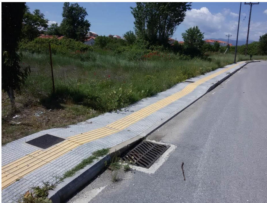
Φωτ. 4.1: Φρεάτιο υδροσυλλογής Βόρειας Περιφερειακής οδού, στην οποία διέρχεται ο υφιστάμενος ορθογωνικός οχετός εσωτερικών διαστάσεων 2x1m.
