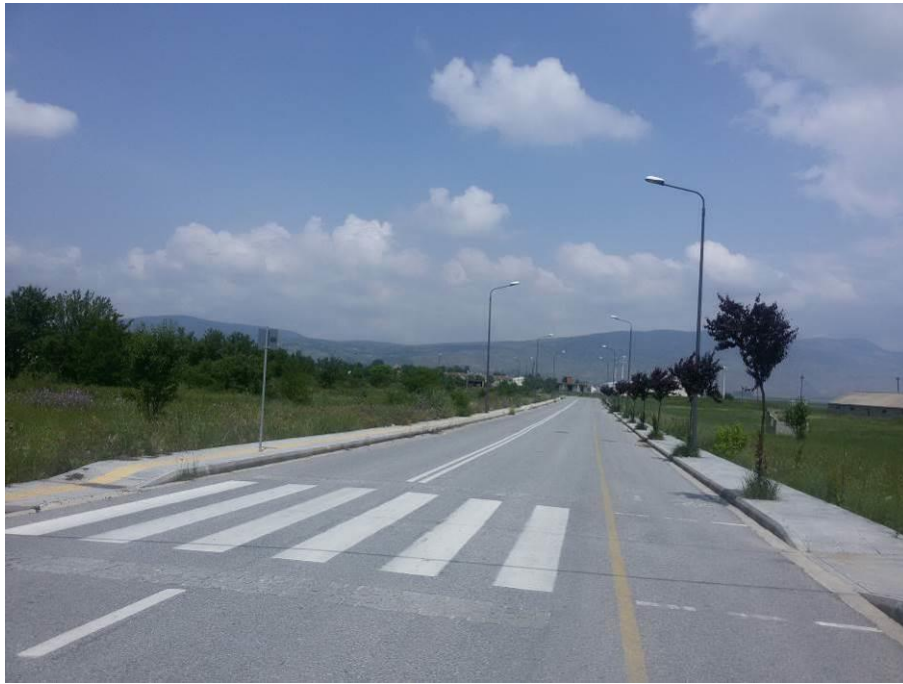
Φωτ. 4.3: Περιφερειακή οδός πλησίον του Ο.Τ. 129 (διέλευση υφιστάμενου σωληνωτού δικτύου ομβρίων και δικτύου ακαθάρτων).
