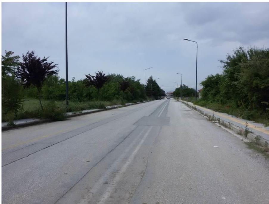
Φωτ. 4.15: Οδός Θανάση Χατζή – ΝΑ περιμετρικό δίκτυο κατασκευής του νέου δικτύου, πλησίον Ο.Τ. 151.
