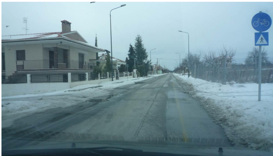
Φωτ. 4.4: ΝΑ περιφερειακής οδός – διέλευση νέου δικτύου ομβρίων.
