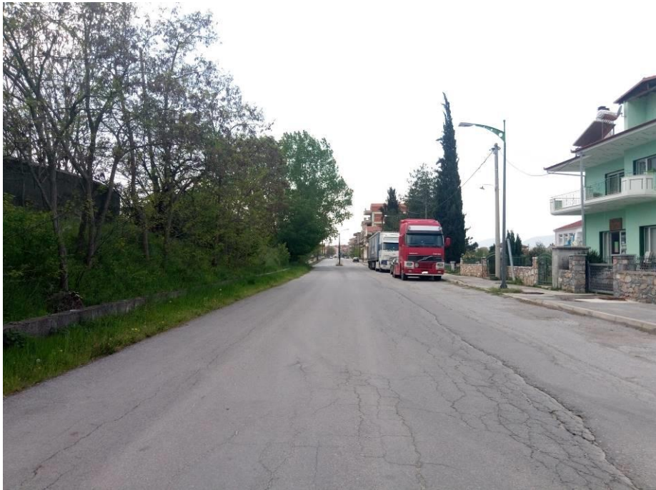
Φωτ. 4.7: Οδός Μεγάλου Αλεξάνδρου, μεταξύ των Ο.Τ 64 και 132, πλησίον των σιδηροδρομικών γραμμών – διέλευση νέου δικτύου ομβρίων.
